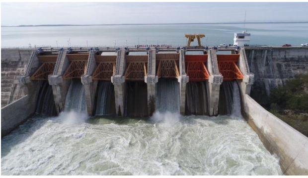
Fig. 1. El Cuchillo dam.
