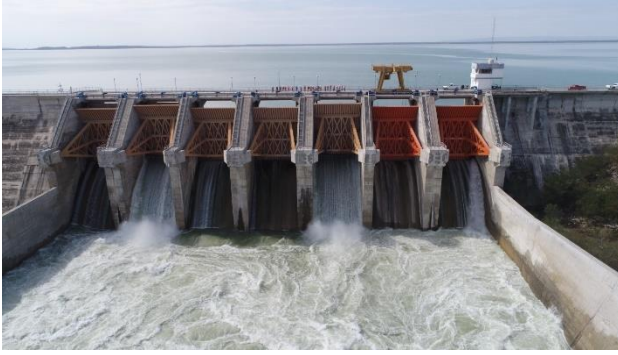
Fig. 1. El Cuchillo dam.
