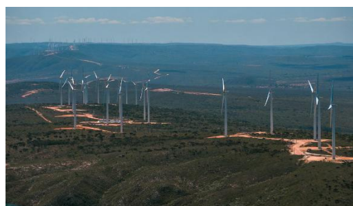
Figura 3: Complexo Eólico Alto Sertão. Atlas Eólico da Bahia - SEINFRA (2013).
